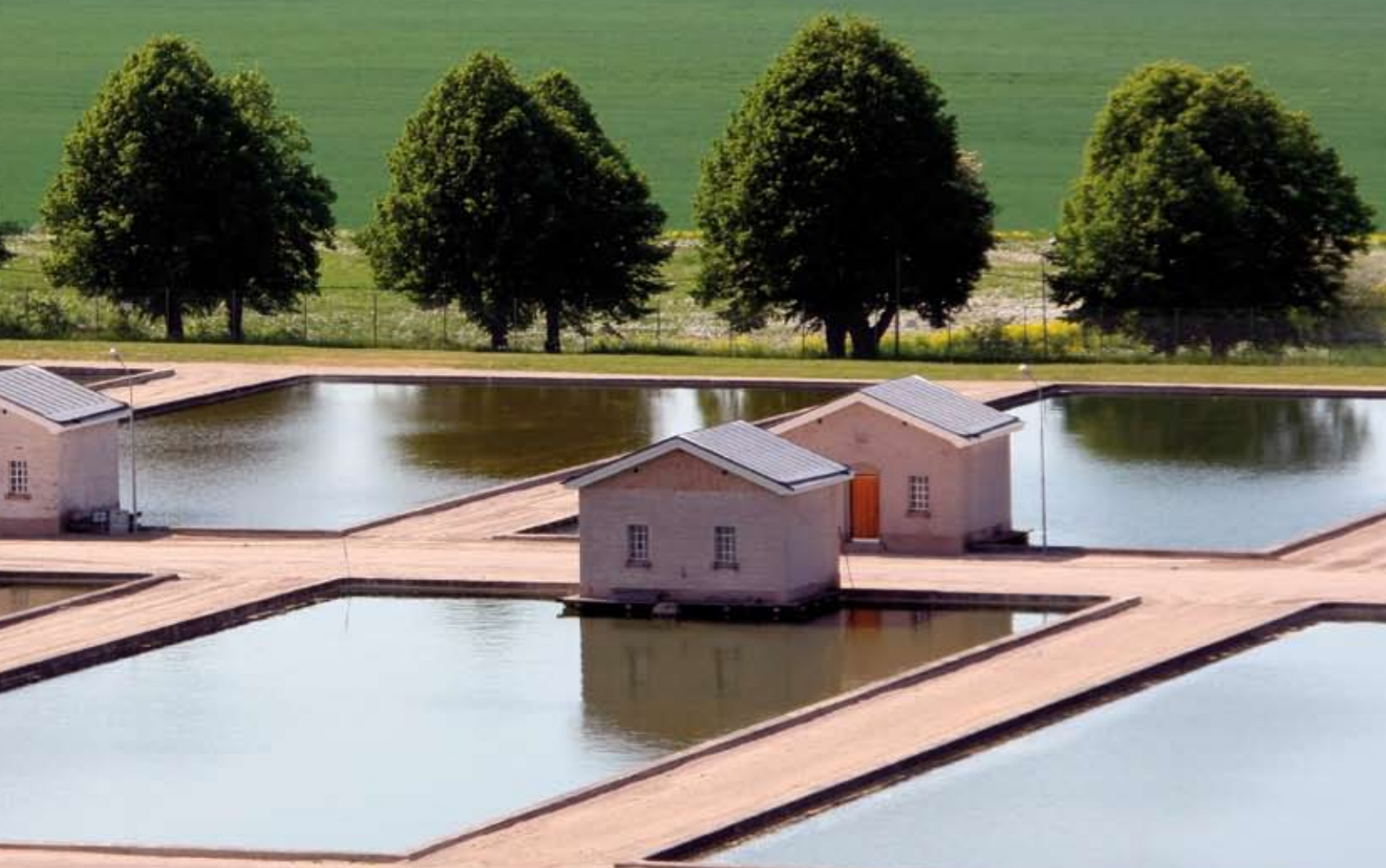
Ved Norsborgs vandværk renses 60 procent af det vand, der forbruges i Stockholm.
